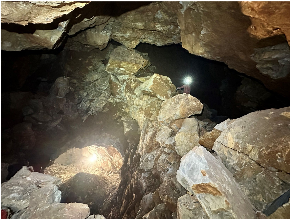
Slika 2.19: Izsutje dna podorne dvorane jame 2TDK-066 v spodaj ležeč osvetljeno glavno cev predora Beka. V času raziskav je bil problematičen dostop v zgoraj ležečo dvorano (nasutje izkopnega materiala za nadvišanje dostopa iz predora, kasneje pa tudi sproščanje do 7 m velikih blokov (na sredini zgoraj, z miniranjem) in neuspešno sidranje razpokanega stropa dvorane (neuspešno zaradi višine in nestabilnosti; foto: M. Prelovšek).
