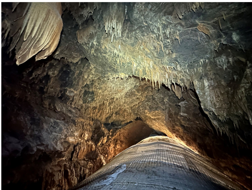
Slika 2.18: Premostitev kapniške dvorane jame 2TDK-080 z armaturnimi loki, mrežo in geotekstilom, ki je na območju stojišča od znotraj že pobrizgan z betonom. Zaradi zatesnjenosti predora z geotekstilom je ohranjenost stropa in sten jame praktično popolna (foto: M. Prelovšek).
