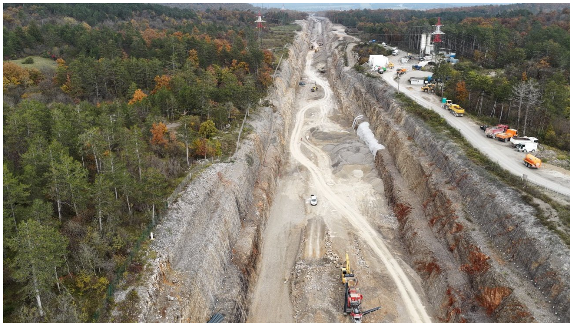
Slika 2.4: Pogled na gradbišče trase od predora T1 v smeri proti Divači novembra 2025 (Foto: dron, A. Košir).
