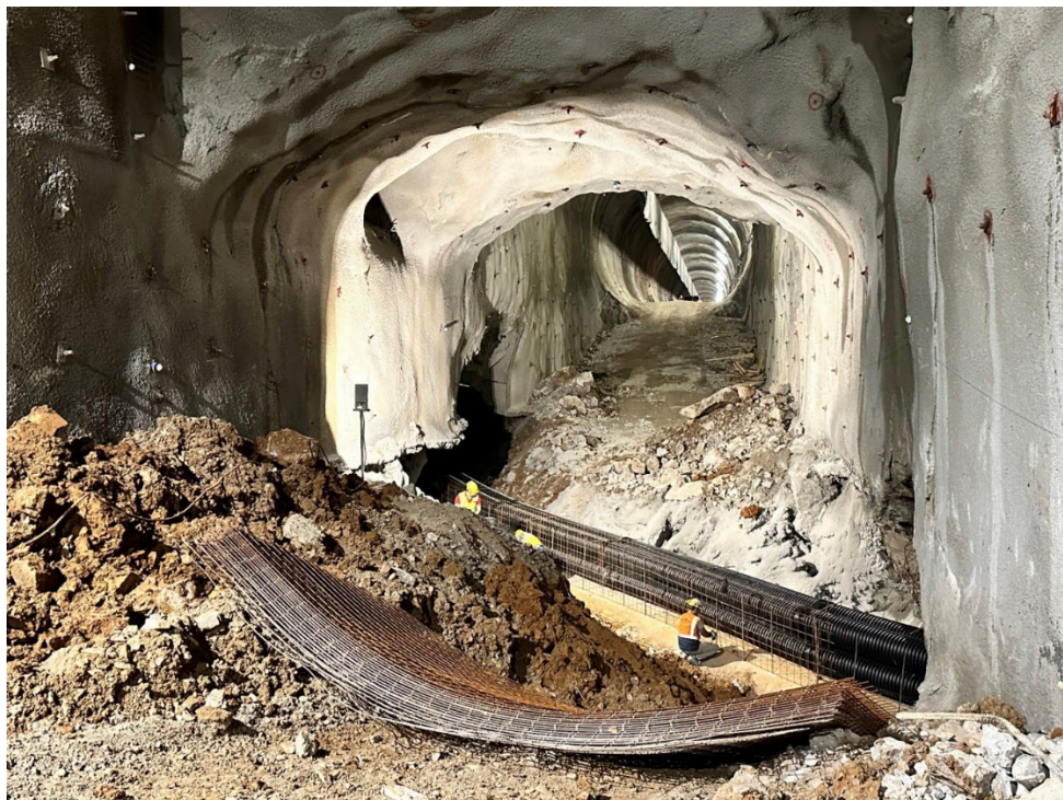
Slika 2.17: Hidrološko premoščanje jame 2TDK-080 na višini dna vodnega rova s štirimi cevmi premera 0,4 m, za kar je bila potrebna poglobitev izkopa in kasnejša ločna premostitvena konstrukcija (foto: M. Prelovšek).
