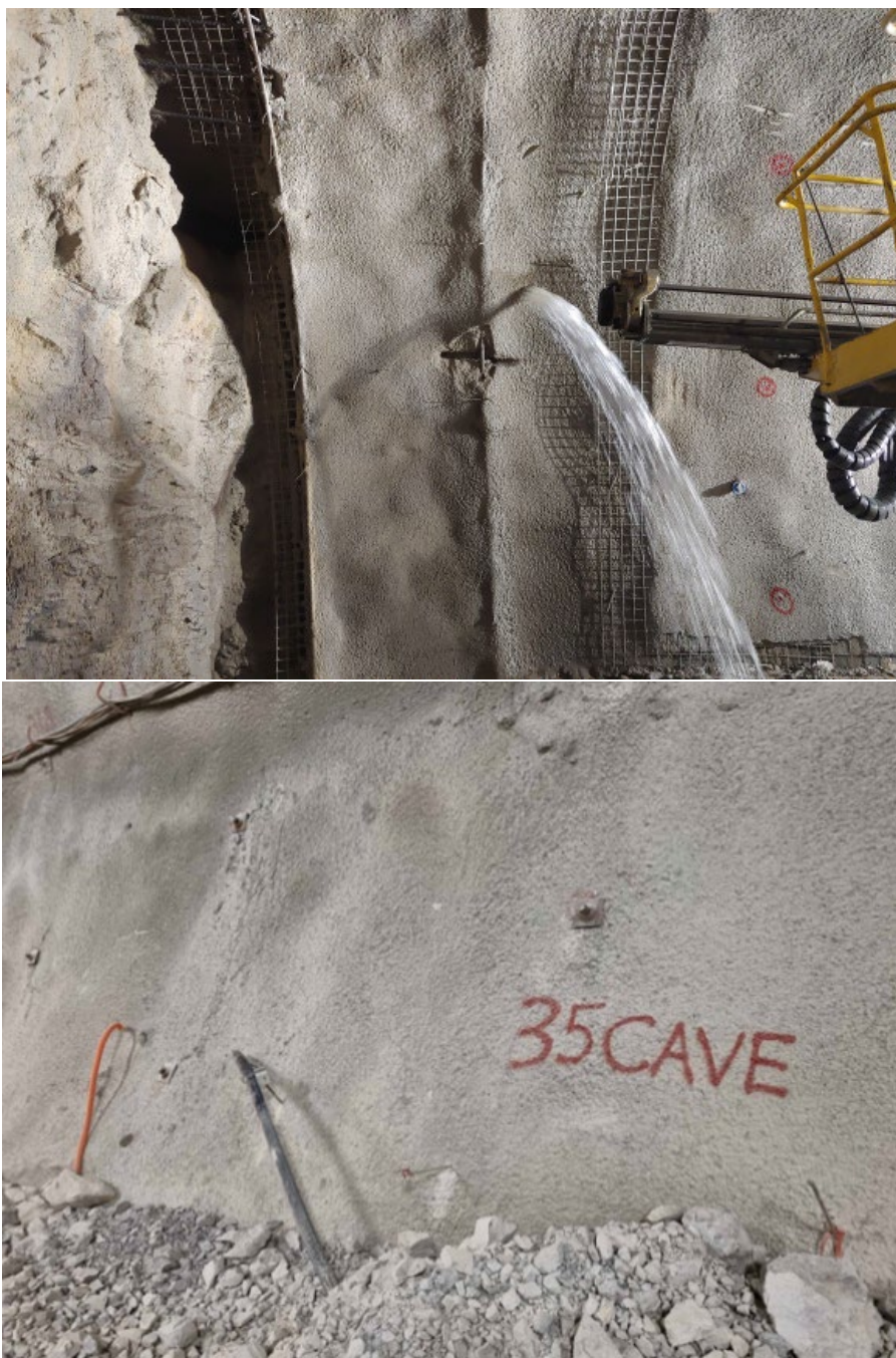
Slika 2.24: Dotok vode in vzpostavljeno mersko mesto hidrostatskih tlakov.
